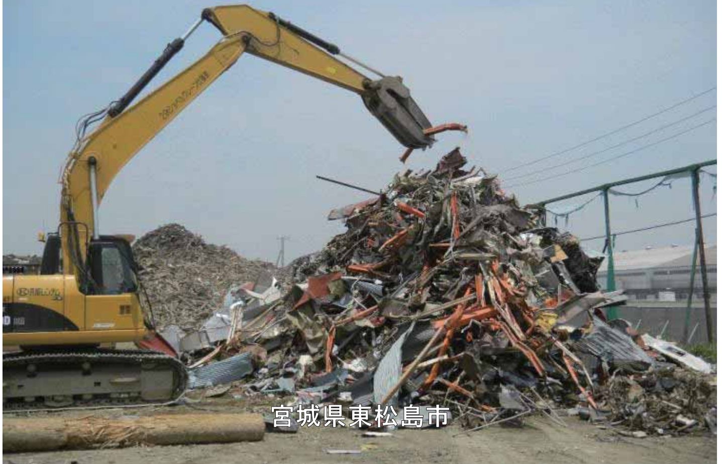
2607_4_018_045055_東松島市_2011.6.9 _大曲浜災害廃棄物仮置場_分別仮置き
