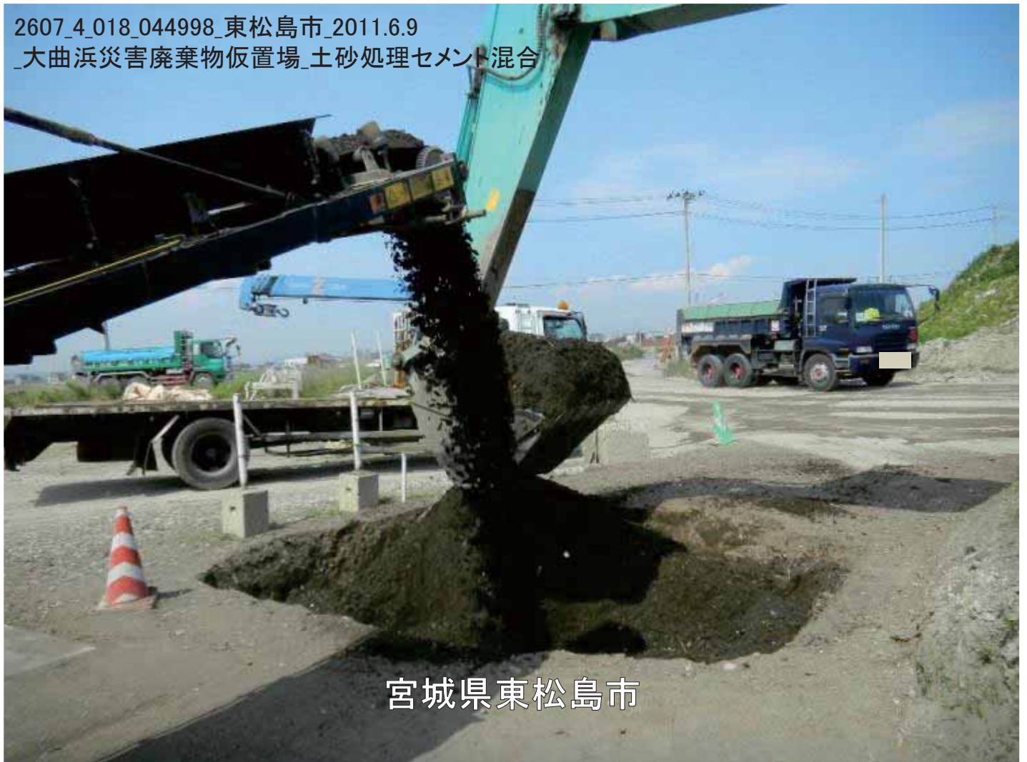
2607_4_018_045000_東松島市_2011.6.9_大曲浜災害廃棄物仮置場_土砂処理セメント混合
